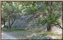
Mur d'enceinte du Beausset-Vieux, XIII ème XIV ème siècle
